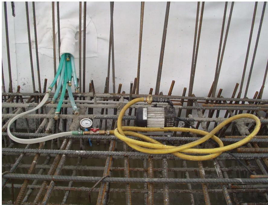
Foto 9. Kontrola těsnosti sektorové hydroizolace po provedení výztuže.
