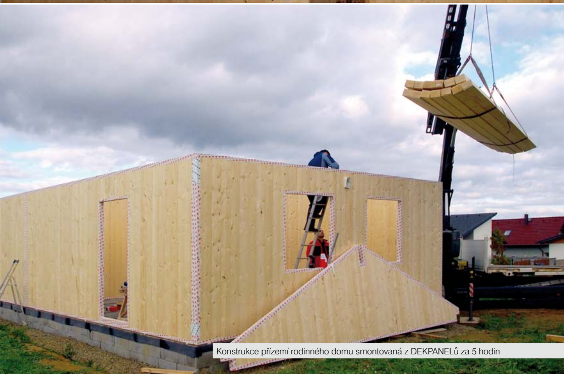
Prvky stropní konstrukce se osazují do předem připravených výřezů v panelech
